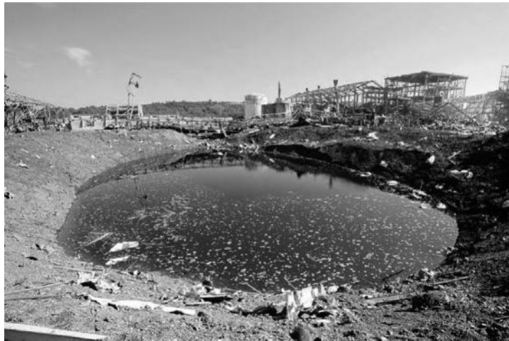
Fig. 19. Cratère de la détonation de nitrate d'ammonium dans l'usine AZF 21 sept. 2001. La force de l'explosion a été estimée à un équivalent 20 à 40 tonnes de TNT (Pasman 2015, p. 11).
